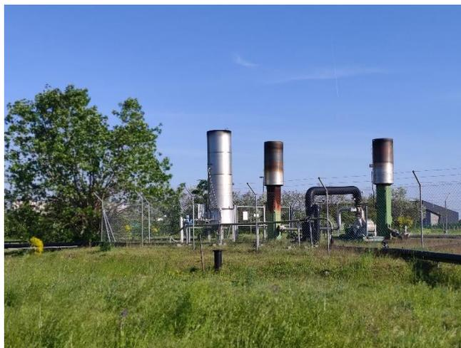
Courant 2019, le SITDCE a réalisé sur le site de l'ancienne décharge le zonage ATEX (risque d'explosion) et le document d'exposition au risque d'explosion (DRPCE). Fin juin 2020 une torchère de plus petite taille et répondant à la réglementation ATEX a été installée en lieu et place de l'ancienne torchère. Une étude de fin de post exploitation du site a été initiée en 2022 et déposée auprès des services de l'Etat en charge du suivi administratif du site.
